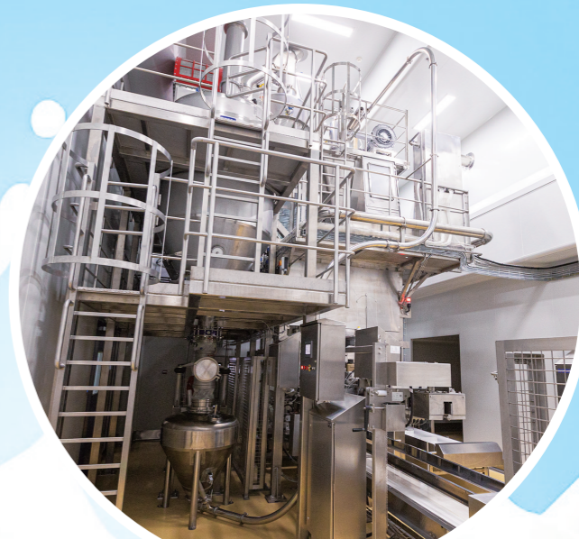
■蒙牛奶立方工厂全自动化罐装区域
