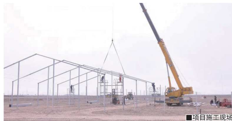
■项目施工现场
