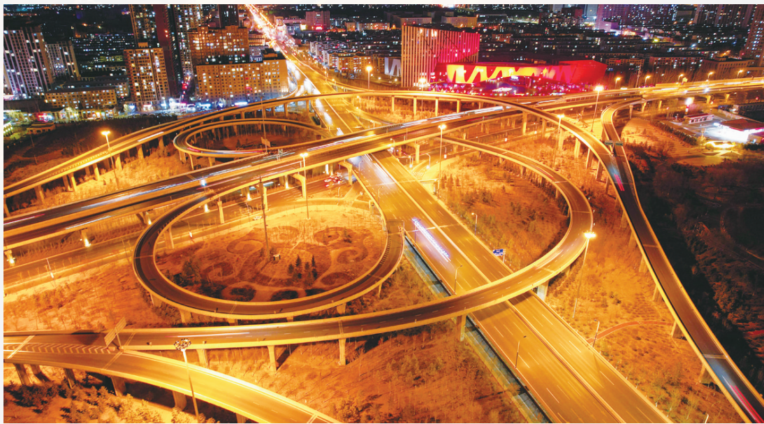
快速路的高架桥
