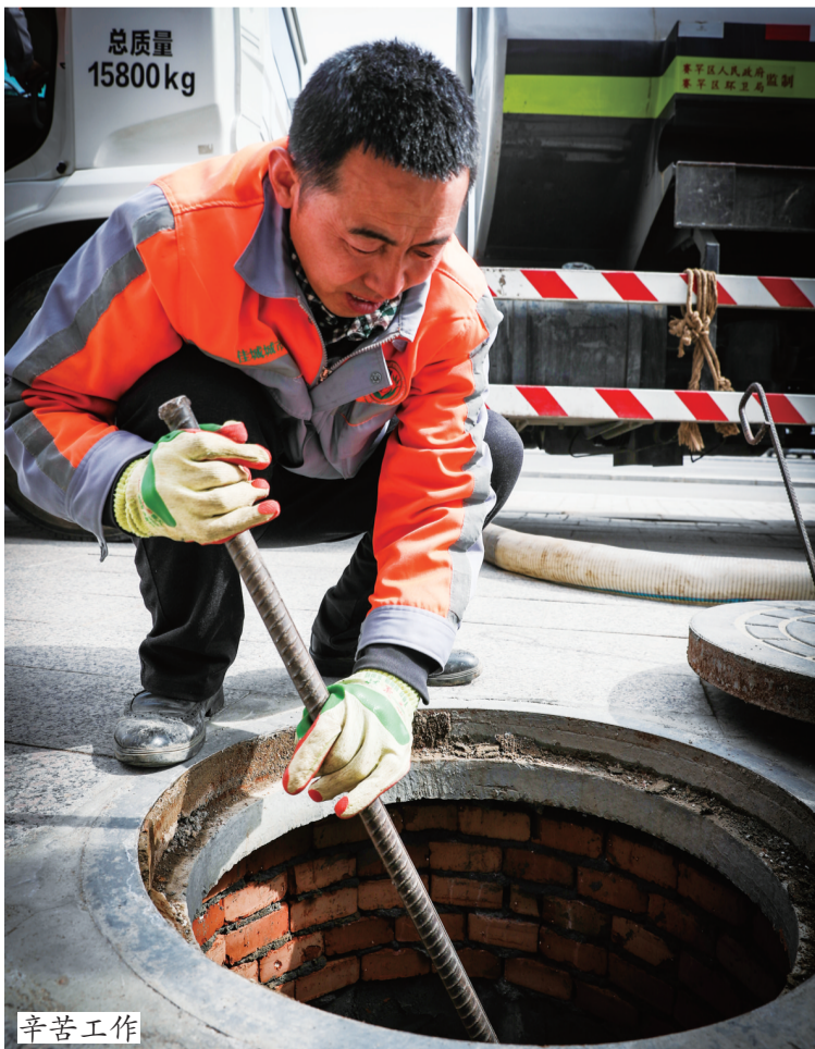
排污管道被疏通，工人们脸上浮现出笑容。
