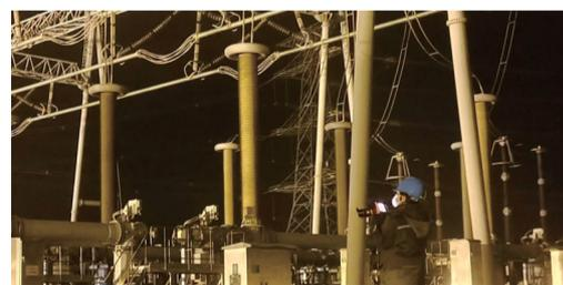
4月20日,内蒙古超高压供电公司检修专业人员对500千伏甘迪尔变电站开展一次设备红外精确测温工作。随着智能电网建设加快,红外精确测温已经成为500千伏主网设备运行状态检测的重要方式,并为设备状态检修提供重要依据。(乔丹)
