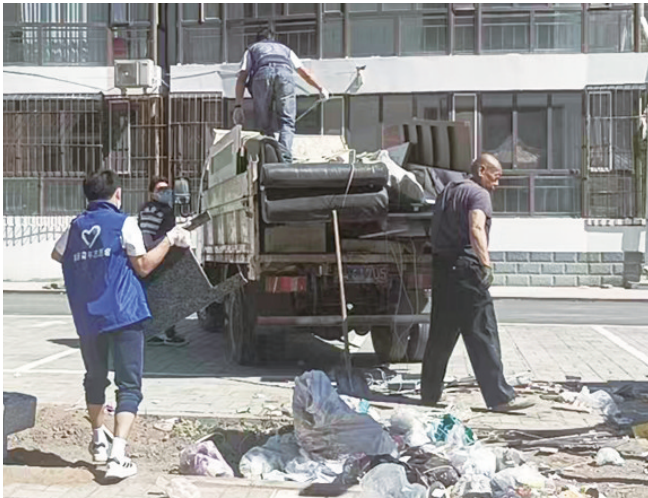
为居民区清运建筑垃圾
