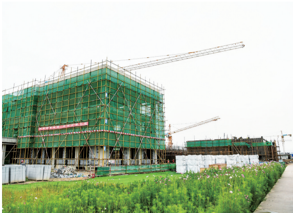
在建的金桥工业污水处理厂项目
