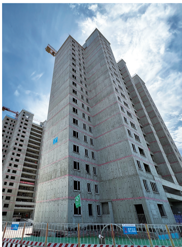
市第一医院南侧棚户区改造及回迁安置房
