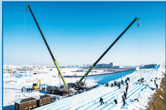
冰滑梯施工现场
