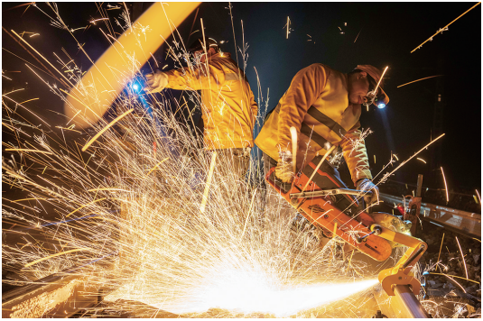
◀1月5日凌晨,在沪昆铁路公坪至芷江西区间,铁路工人使用切割机进行锯轨作业。 陈思汗 摄
