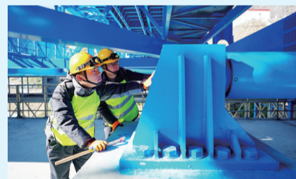
工区职工赵润泉(左)、罗星海在查看大桥阻尼器。
