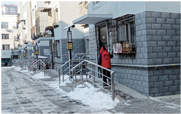
单元门前改坡道装扶手
