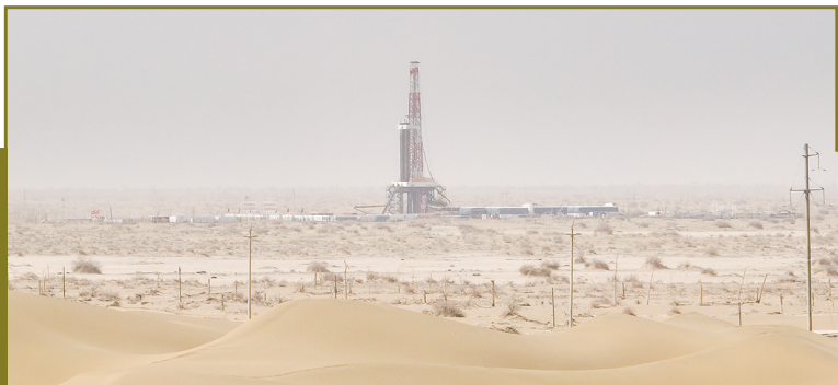
这是3月2日在新疆克拉玛依沙漠拍摄的深地塔科1井
