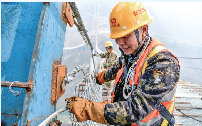
工人在花江峡谷大桥的猫道上施工
