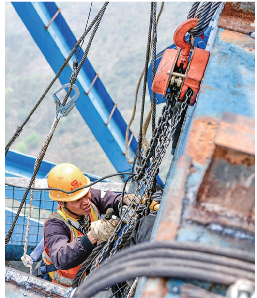
工人在花江峡谷大桥的桥塔上施工
