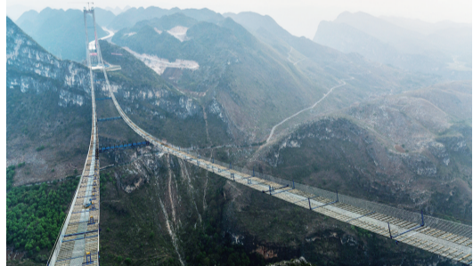
花江峡谷大桥建设场景
