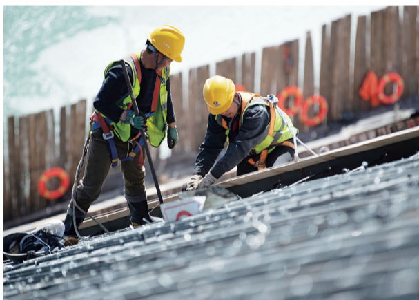
玛尔挡水电站工作人员在坝体上施工 潘彬彬 摄
