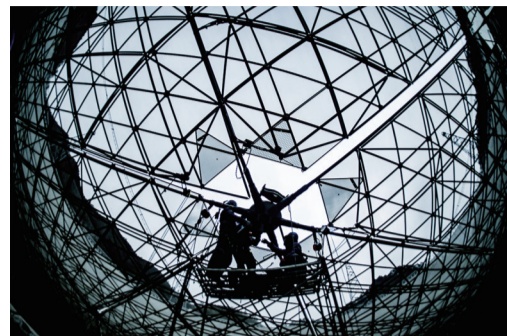
工作人员对“中国天眼”进行维护保养
