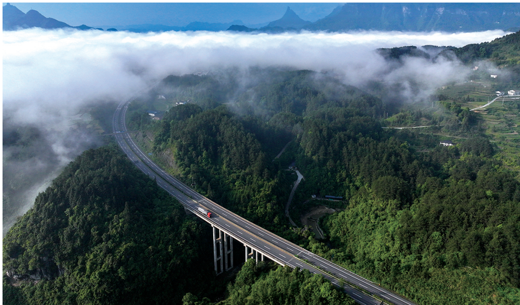
重庆市南川区金佛山东麓云海景观和山间高速公路交织 刘潺摄
