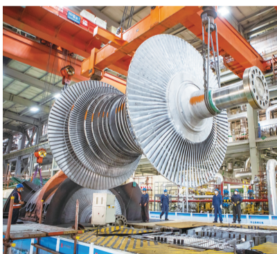
进行吊装作业
