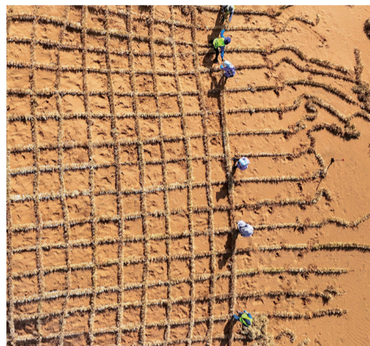
治沙工人在宁夏中卫市境内的腾格里沙漠铺设刷状网绳式草方格沙障
