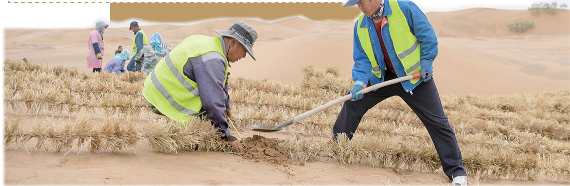
治沙工人在将刷状网绳式草方格沙障的两端用沙子压住
