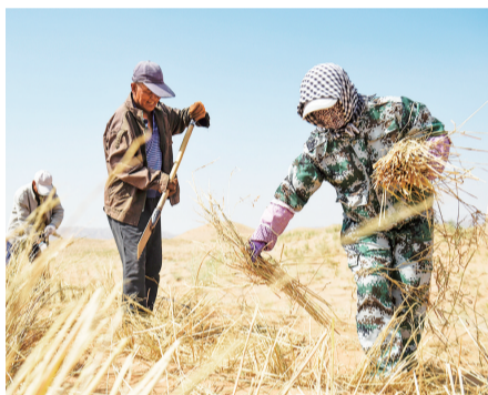
治沙工人在宁夏中卫市长流水沙区扎制草方格
