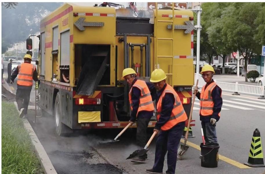
本报讯(记者 马妍)9月12日,在成吉思汗大街,一台热再生综合养护车正在作业,有了它的加持,一段破损路面用时不到半小时就修补完成,极大提高了日常道路修补养护的工作效率。
