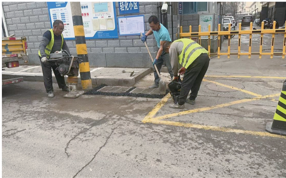
维修下陷井盖
